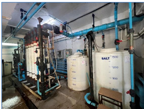
ระบบปรับปรุงคุณภาพน้ำและถังเก็บน้ำดีที่ผ่านการกรองแล้ว
